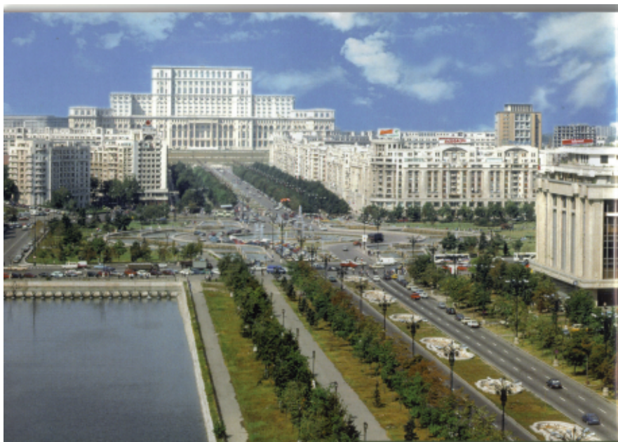
Palatul Parlamentului - București (Palazzo del Parlamento rumeno), voluto da N. Ceaușescu. Iniziato nel 1984 radendendo al suolo parte degli edifici preesistenti
